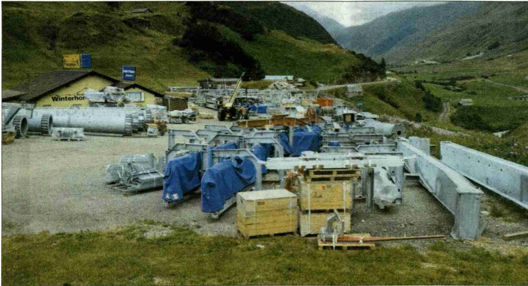
Bei der Talstation Winterhorn in Hospental befindet sich der Installationsplatz mit den Anlageteilen der neuen Sechsesselbahn. Hier laufen die Vormontagearbeiten. FOTOS: MATHIAS FÜRST
