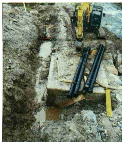
Die Bauarbeiten beim Pumpenhaus an der Unteralpreuss haben begonnen.
