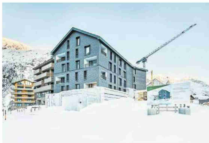
Das Apartmenthaus «Schneefalke» ist bald fertiggestellt. (17. 1. 2017)
