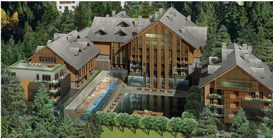
Das Hotel Chedi soll als Erstes gebaut werden. (Bild: Orascom)
