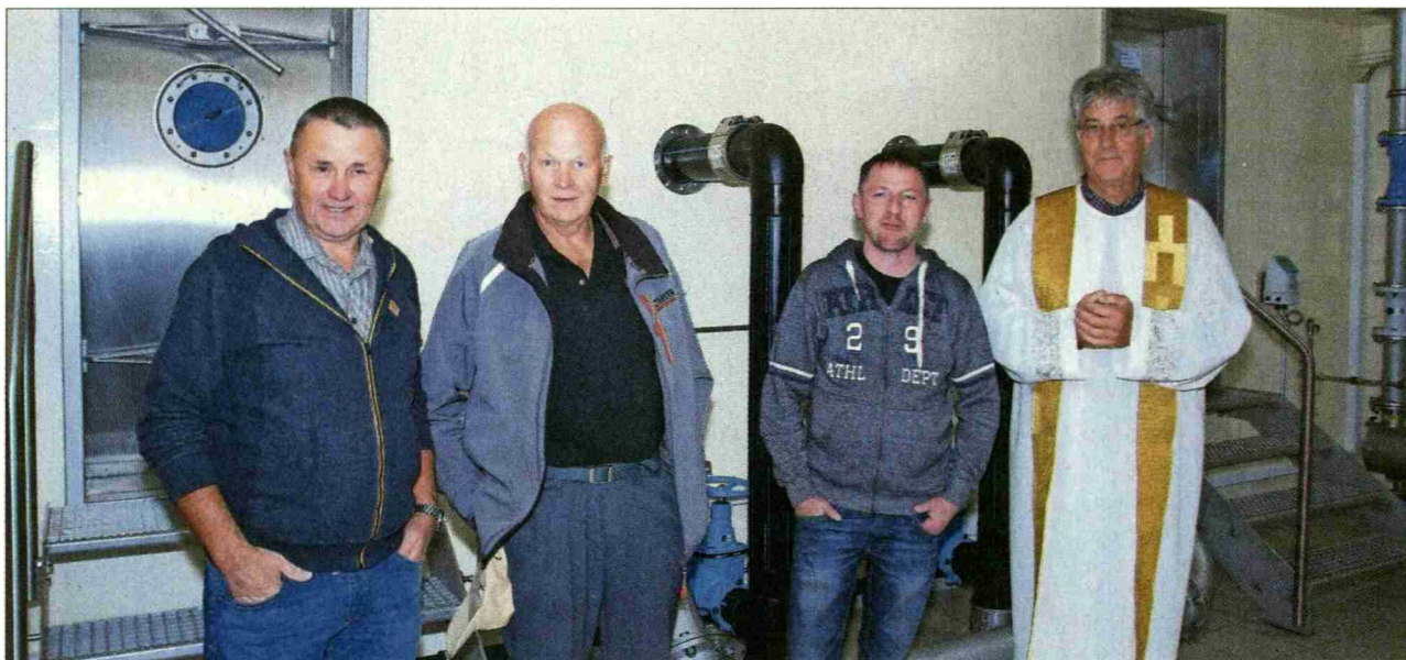
Karl Poletti (Projektleitung Wasserversorgung Andermatt/Hospental), Toni Simmen (Wasserkommission), Beda Regli (Gemeindepräsident) und Diakon Edy Imhof bei der Einsegnung.
